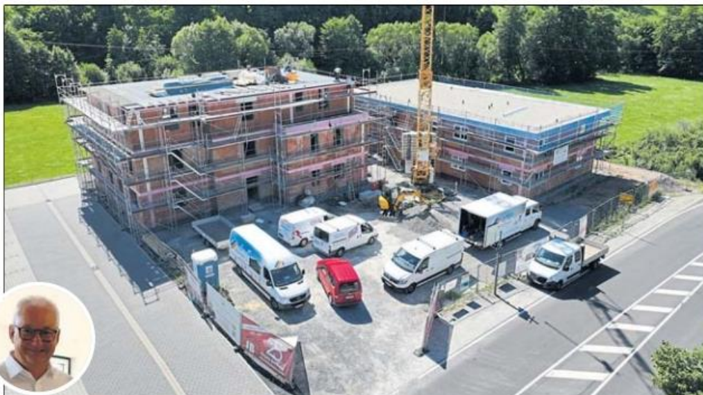
Ein aktuelles Großprojekt: Zwei Wohnhäuser mit insgesamt zwölf Wohnungen entstehen in Poppenhausen.
